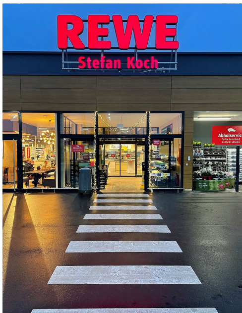
Habona Fondsobjekt | Rauschenberg
